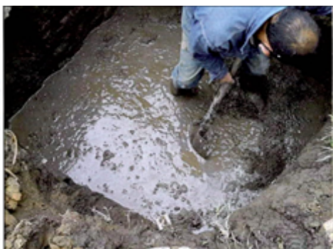
Foto No. 7. Impermeabilización del área
