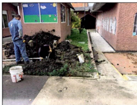
Foto No. 2. Excavación de 1.5 m * 1.5 m * 1.0 metros
