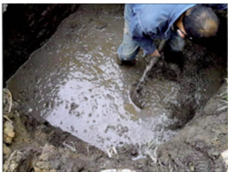
Foto No. 7. Impermeabilización del área
