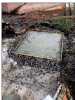
Foto No. 9. Nivelación a ras de piso
