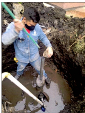
Foto No. 3. Relleno con grava
