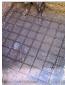
Foto No. 6. Refuerzo malla
