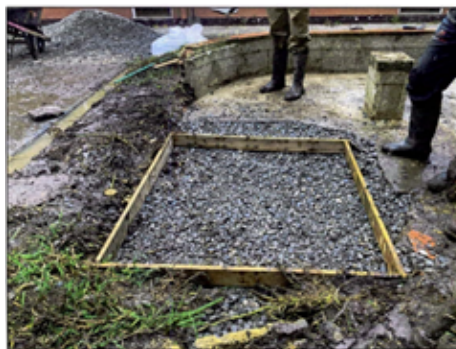
Foto No. 8. Formaleta de sellamiento
