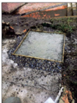
Foto No. 9. Nivelación a ras de piso
