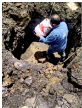
Foto No. 5. Relleno alrededor del pozo
