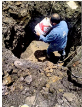
Foto No. 5. Relleno alrededor del pozo
