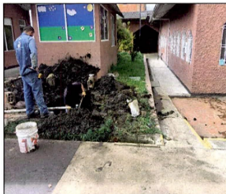
Foto No. 2. Excavación de 1.5 m * 1.5 m * 1.0 metros
