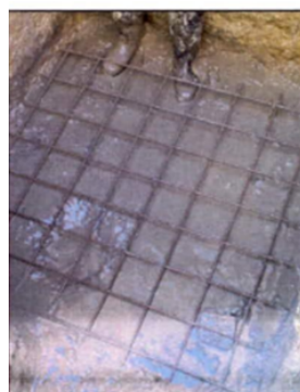
Foto No. 6. Refuerzo malla
