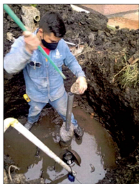
Foto No. 3. Relleno con grava
