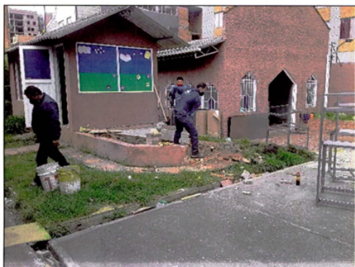
Foto No. 1. Demolición de la piletta
