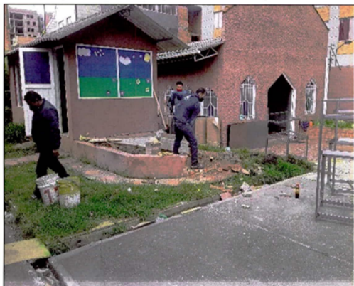
Foto No. 1. Demolición de la pileta
